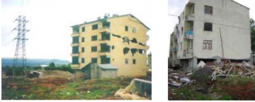
Şekil 22 - 1 Mayıs 2003 Bingöl depreminde, Bingöl merkez ilçesi Saray mahallesinden yamaç kret noktasına yakın göçme ve ağır hasarlı Betonarme bina örnekleri [41]
