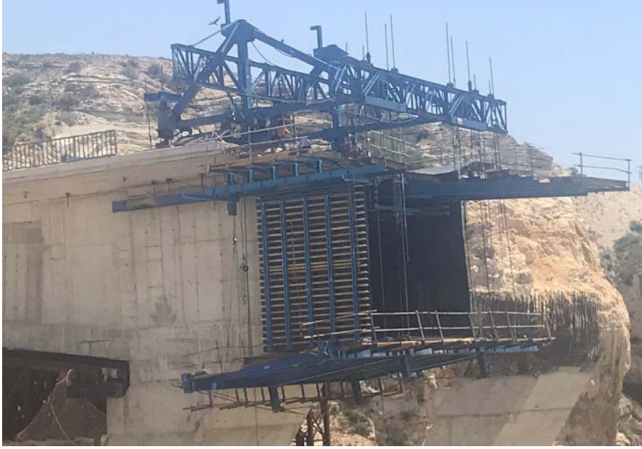
Şekil 8 - Çayırhan Köprüsünde kullanılan hareket ettirilebilir kalıp arabası
