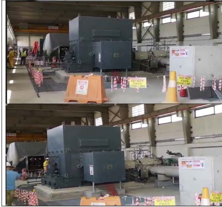
Şekil 3 - İnşaat Yapım Aşamaları-2
