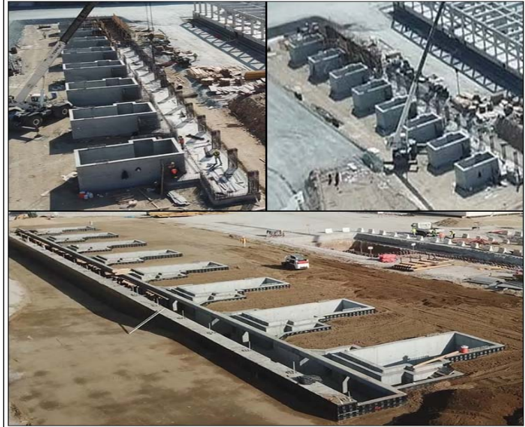
Şekil 2 - İnşaat Yapım Aşamaları-1
