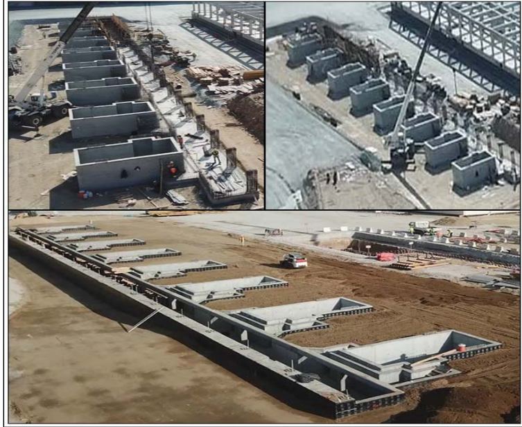
Şekil 2 - İnşaat Yapım Aşamaları-1
