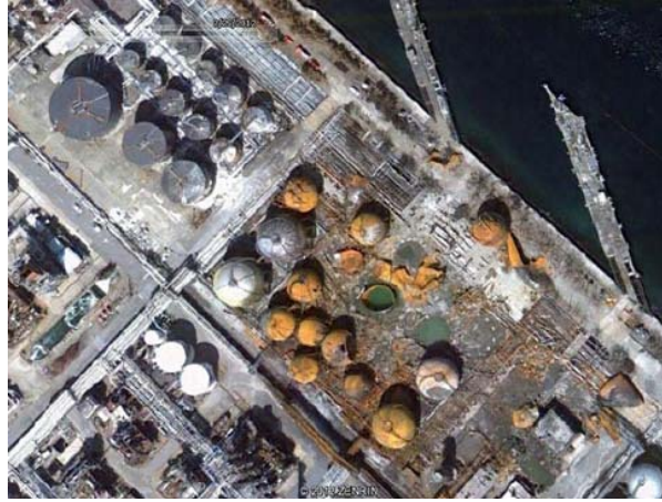
Şekil 1 - Chiba rafinerisinde deprem sebebiyle meydana gelen yangın ve patlamalarda etkilenen tanklar [6]
