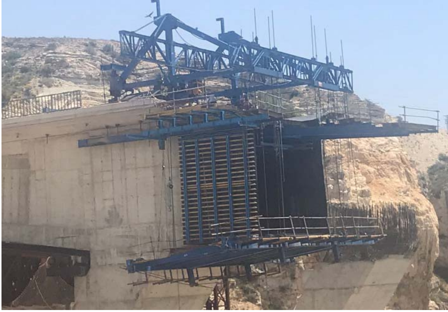
Şekil 8 - Çayırhan Köprüsünde kullanılan hareket ettirilebilir kalıp arabası
