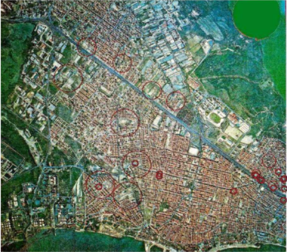
Şekil 13 - Avcılar bölgesinin hava fotoğrafı, yerleşim alanlarının Şekil 11 ve 12' de gösterilen eğimli arazi üzerinde yayılımı [36].
