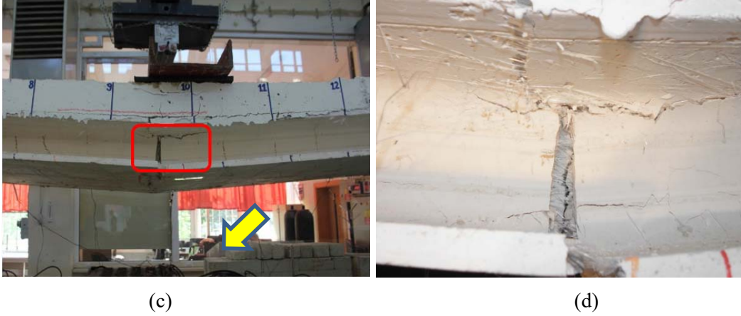
Şekil 7 - Numunenin (a) deney öncesi ( P=0 kN, \delta=0 mm), (b) deney sonu ( P=66.5 kN, \delta=155.3 mm) görünüşleri, (c) deney sonu panel sisteminin orta bölgesindeki çatlak, (d) panel ve içindeki beton çatlaklarının yakından görünüşü
