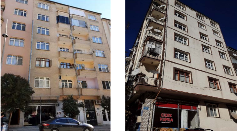
Şekil 1 - İzzetpaşa Mahallesi Tipik Bina Fotoğrafları
